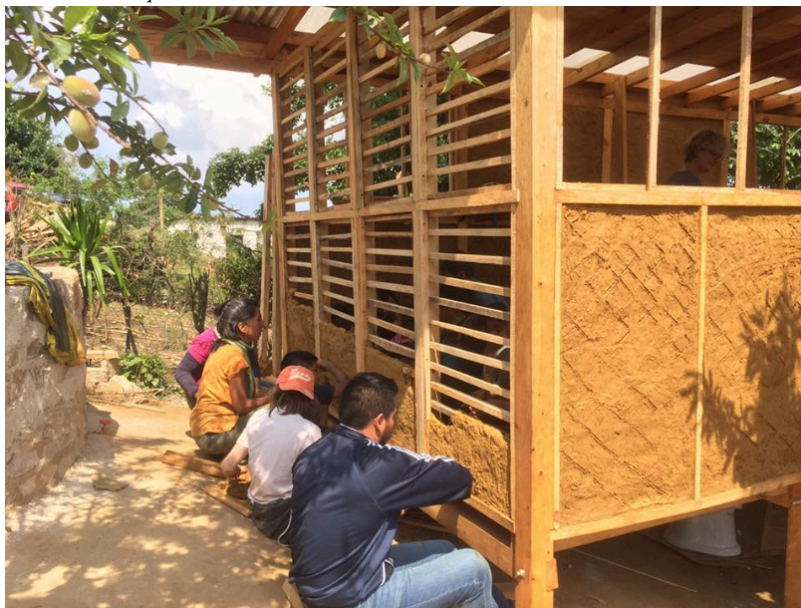
Figura 3 Construcción de muros de bahareque
