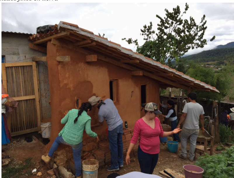
Figura 4 Aplicación de aplanados finos en tierra
